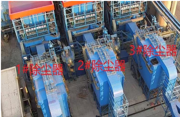
动力站锅炉除尘及脱硫装置
