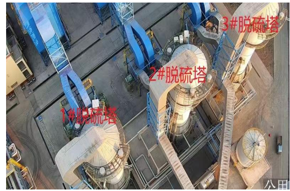
动力站锅炉除尘及脱硫装置
